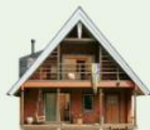
BESS 一棟貸しモデル
