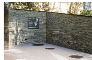
マンホールトイレ
