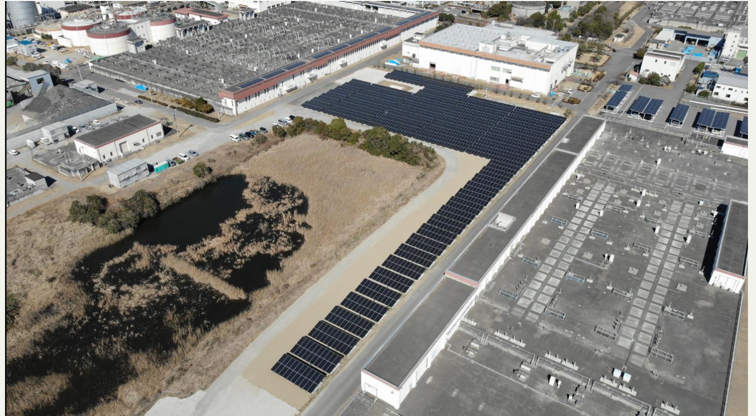
「千葉市南部浄化センター」の太陽光発電設備
