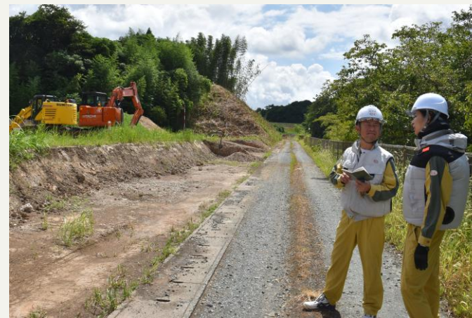
進入路の造成工事
