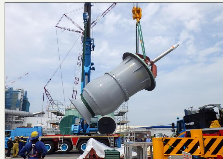
循環水ポンプ据付
