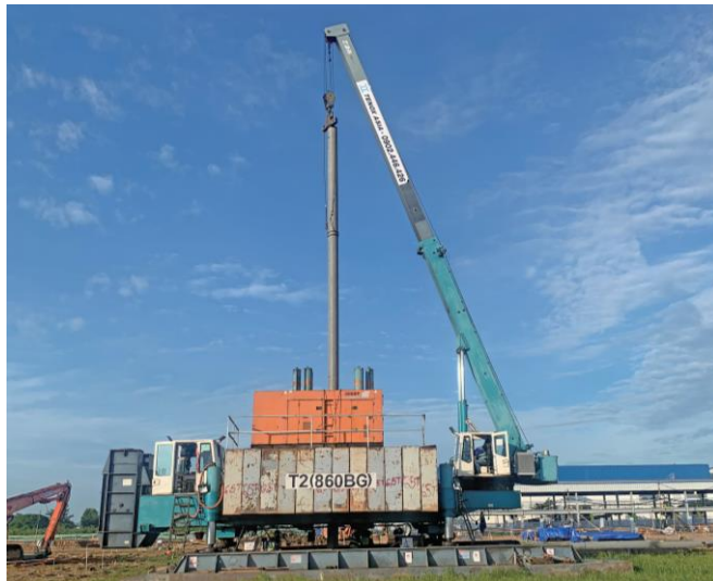
日系企業発注プロジェクト コンクリートパイル圧入施工
