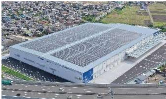
倉庫屋根全面に3,146KWのメガソーラーを敷設。
