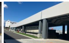
2階へ直接乗入れ可能なスロープ
