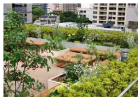
虎ノ門トーセイビル（2006年築 事務所）
