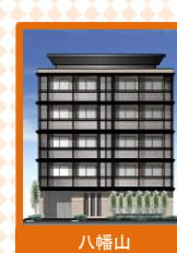
八幡山 学生マンション
