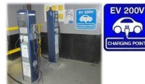
電気自動車用充電設備設置 (東急プラザ赤坂)
